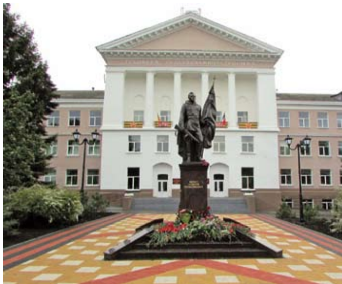
Здание ростовского Института Защиты Предпринимательства (РИЗП)
